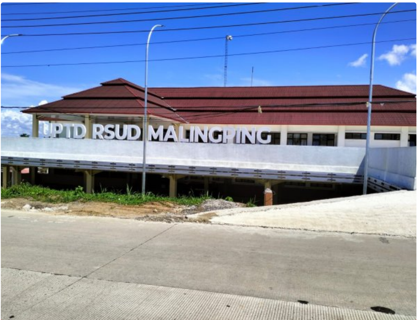
Gedung parkir RSUD Malingping yang sudah diresmikan
